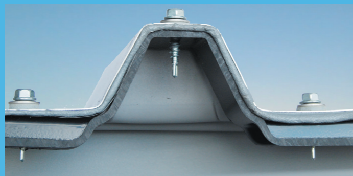
Крепление к кровельным панелям
