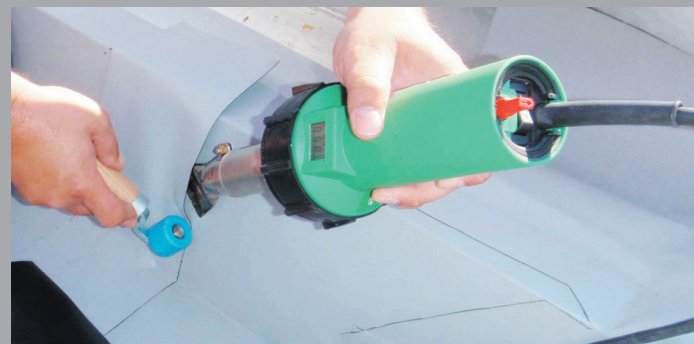
Сварка стыков водостока
