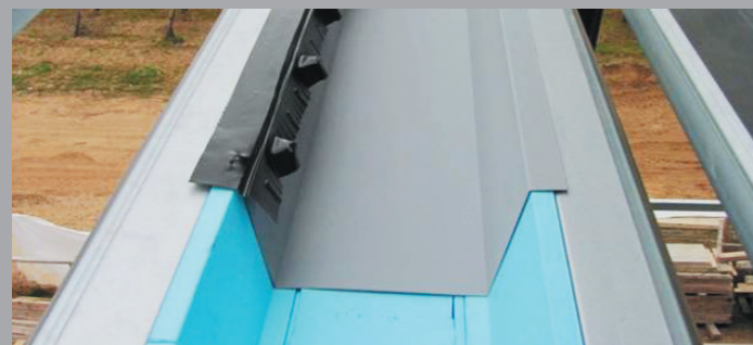
Установка теплоизоляции и основного желоба
